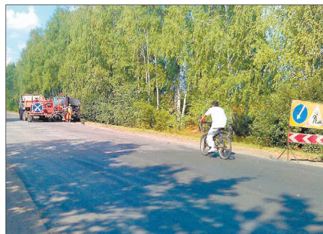
Ямочный ремонт дороги на въезде в город со стороны Носовихинского шоссе.
