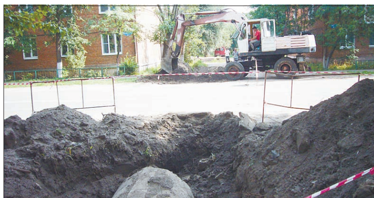
Ремонт теплотрассы на улице Коммунистической.
