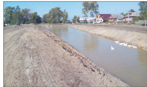
Прочистка канала от родника до пруда в деревне Понарино.
