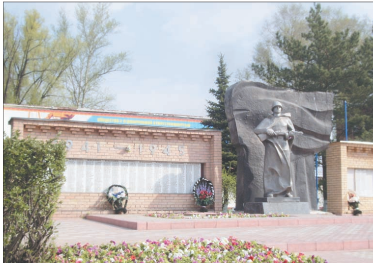
Памятник до реконструкции.
