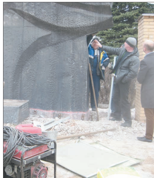
Идут восстановительные работы.
