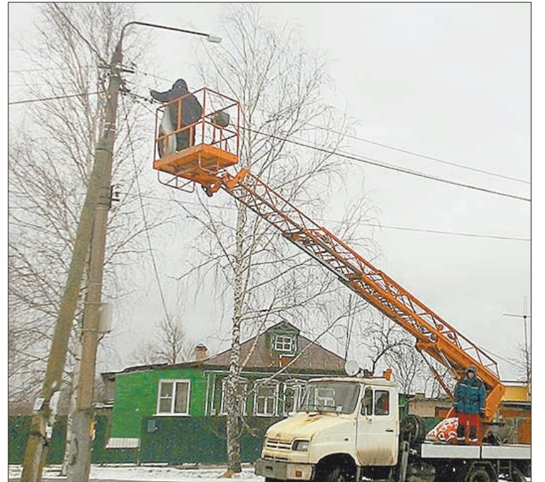
Замена светильников уличного освещения.
